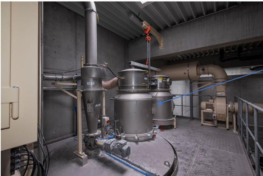
Gleiche Bauart des Drehfilters nur als Filter über dem Abscheider der BB Befüllung
