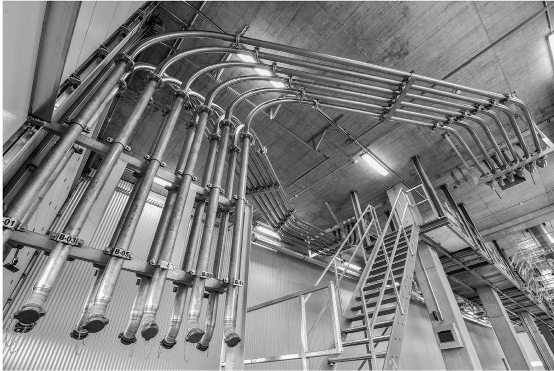
Über diese Rohrleitungen können die Silos auf aus Tankwagen befüllt werden. Komplett mit überwachtem Anschlussstutzen.
