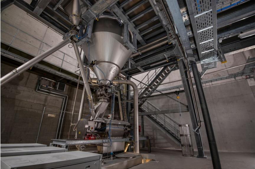
Abscheider für Produkt zu der Sackbefüllung mit Kontrollsieb
